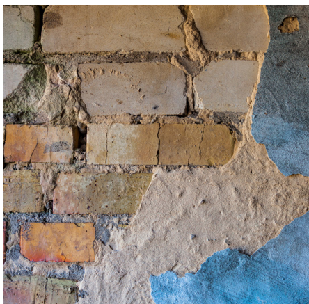
Afgebrokkeld stucwerk
